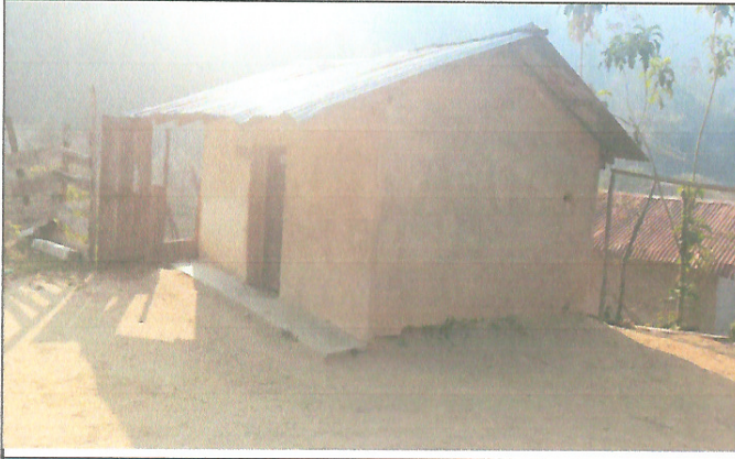
Foto 1: mejoramiento de aula.
