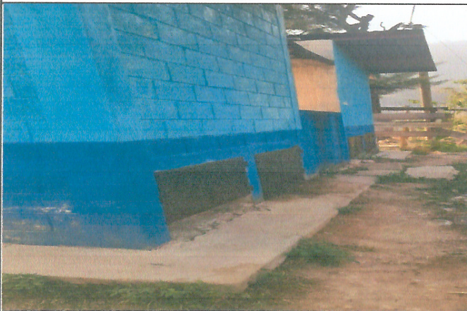
Foto 3: Mejoramiento de servicios sanitarios
